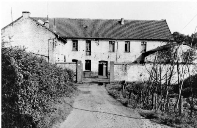
Bis 1946 hatte die Schleiferei keine Probleme. Doch dann war der Mühlenbetrieb nicht mehr möglich, da das Gebäude sich durch Grubenschäden gesenkt hatte und das Mühlrad sozusagen im Wasser stecken blieb.
