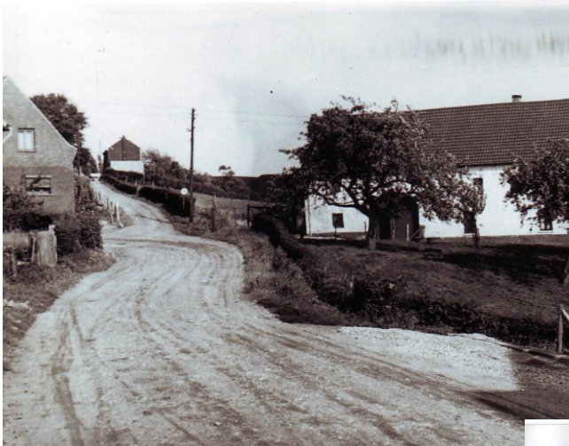
Broichbachtalstraße, rechts Bauernhof " Et Höffje " Dieser Bauernhof Kessels ist heute noch intakt.
